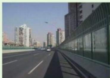
图1-32 高架桥上的隔音屏
